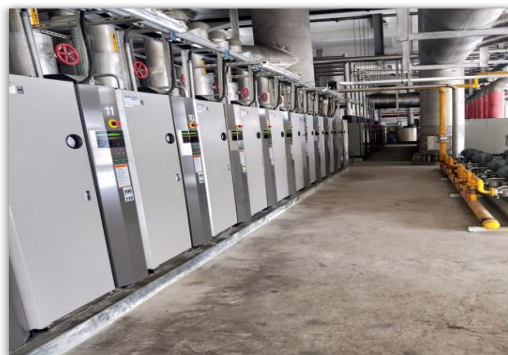
天然氣貫流式鍋爐(18台2.5噸)
