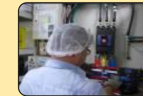
風機電力量測
