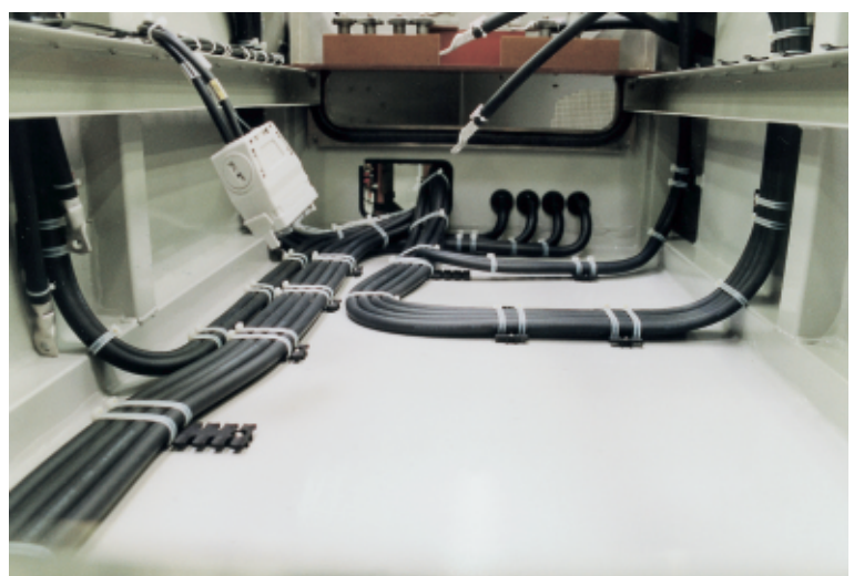
▲ZL 電纜固定架讓長距離電線裝配更堅固、整齊美觀。
