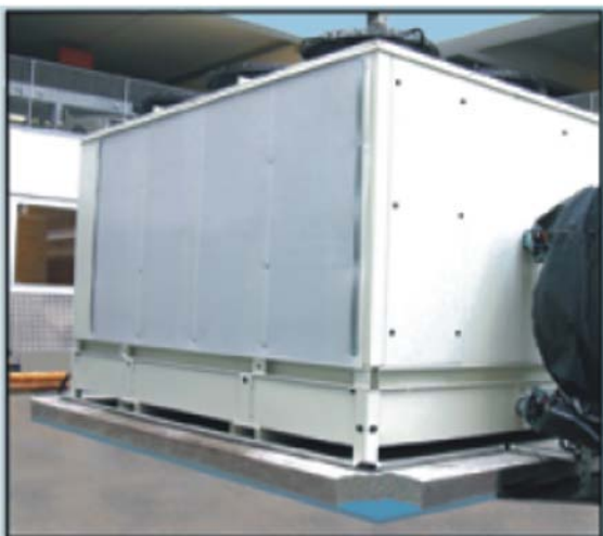
氣動輸送設備安裝隔離墊材
