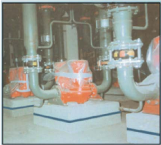
泵浦設備安裝隔離墊材
