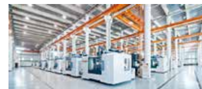
高鋒工業 - A棟立式加工中心廠房
